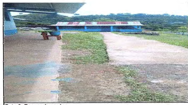
Foto 6: Rampa de cocina.
