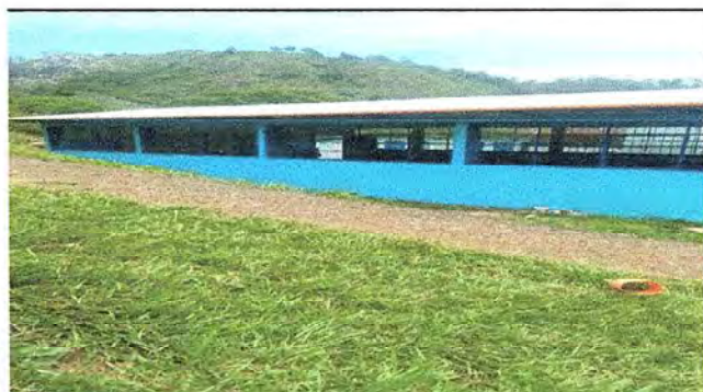
Foto 3: Colocacion de tubo pvc para baja de agua fluvial.
