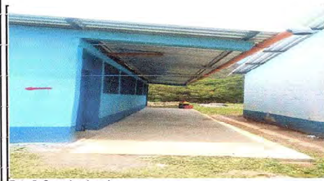
Foto 5: Corredor de aula.
